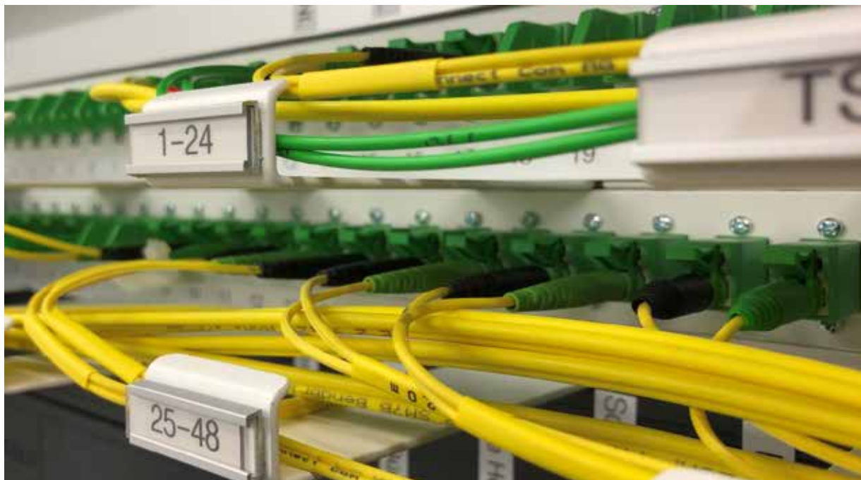
LWL Kabelendverschlüsse im Rechenzentrum der RTB
