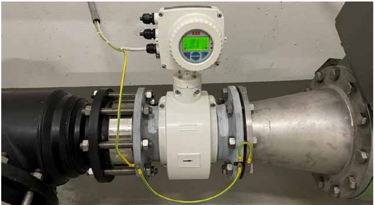
Durchflussmesser Reservoir Boll, Niederlenz
