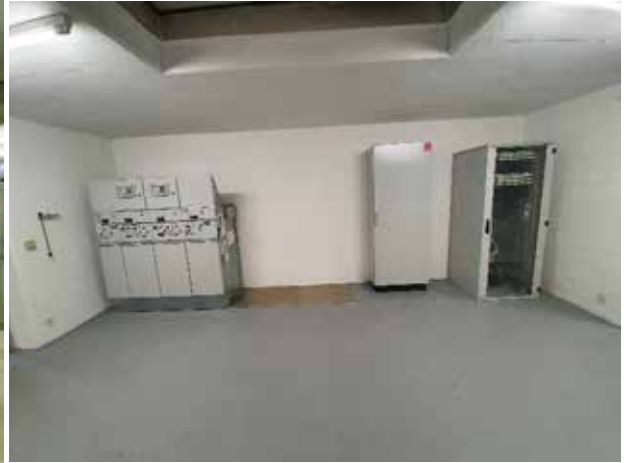
TS Schulhaus, Niederlenz nachher
