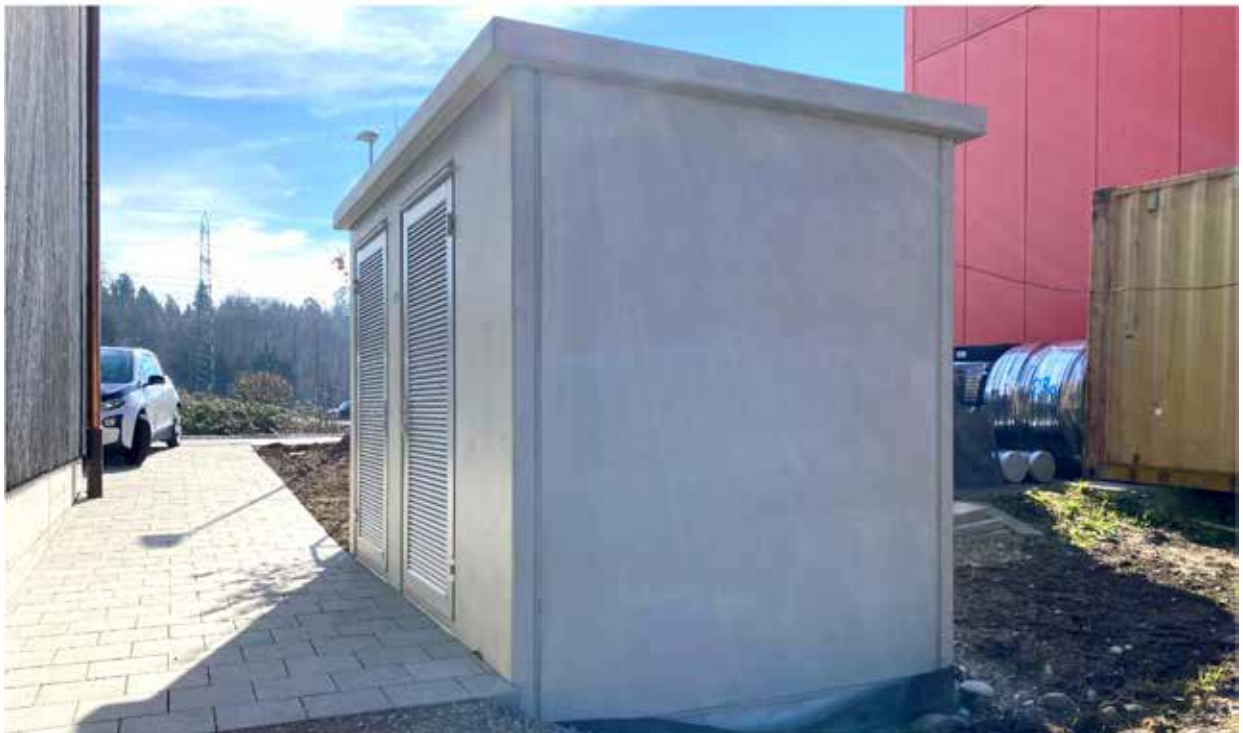
Neubau TS Hardstrasse, Wildeg
