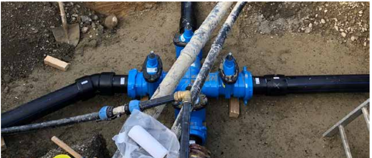
Schieberkombination Böllistrasse, Niederlenz
