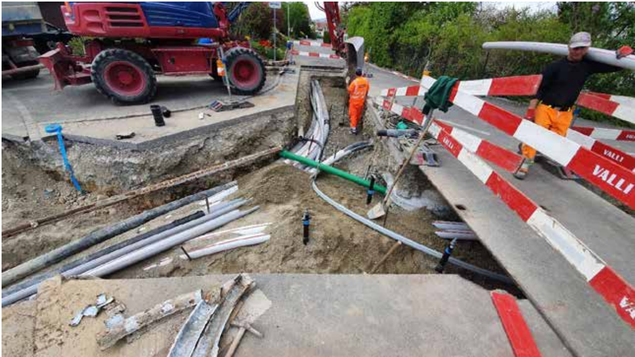
Leitungsbau Knoten Rothackerstrasse – Böllistrasse, Niederlenz
